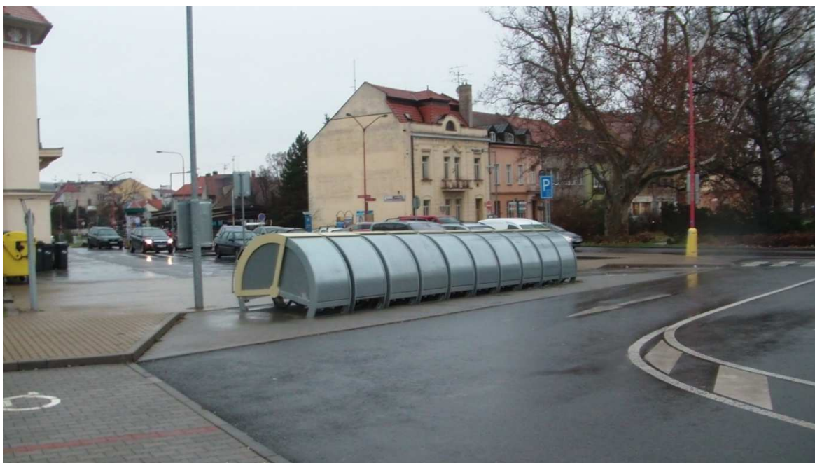
Obrázek 46: Moderní, zastřešená úschovna kol s kapacitou 20 míst v železniční stanici Uherské Hradiště
