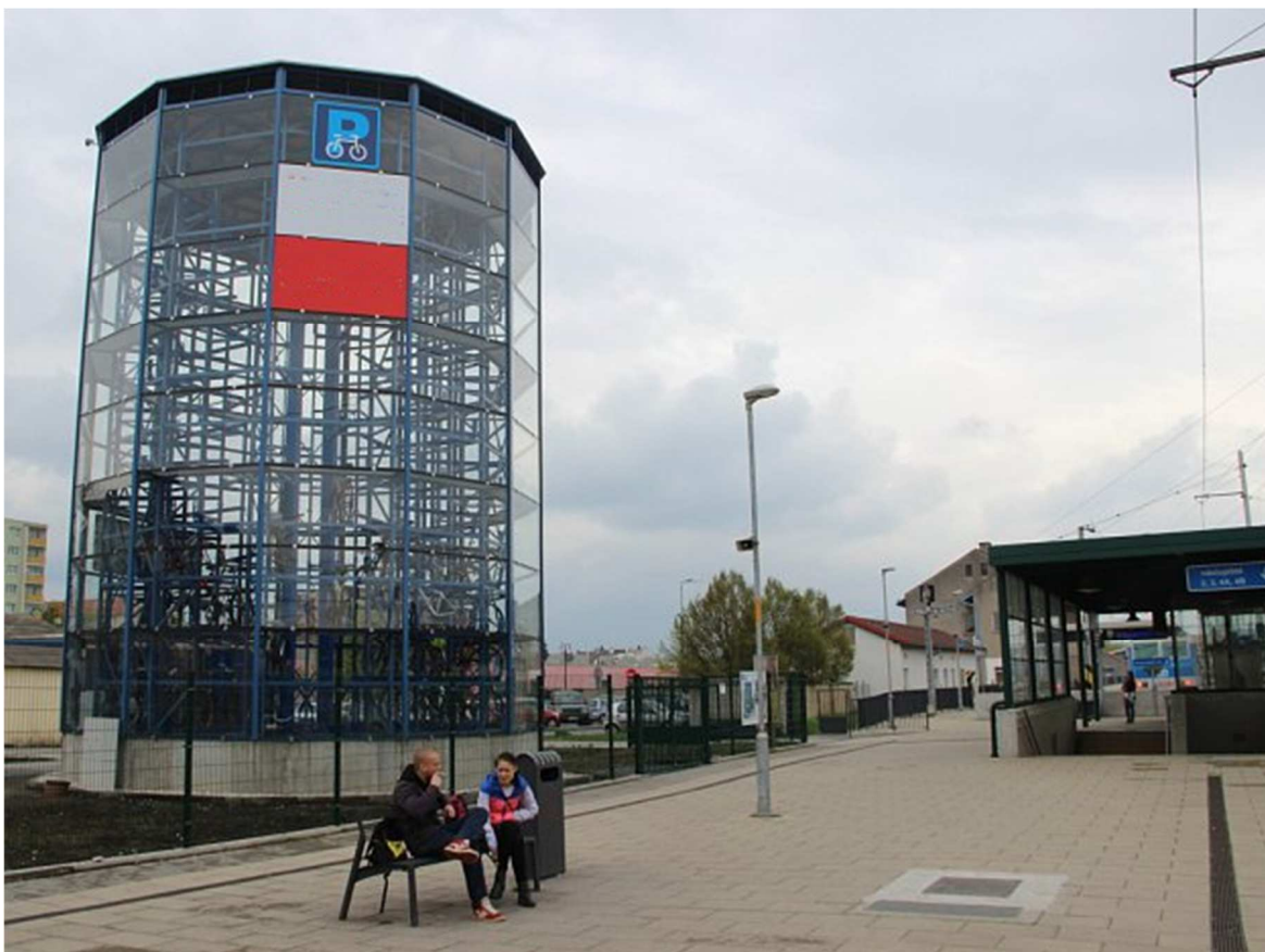
Obrázek 47: Příklad parkovacího domu kol u nádraží Přerov s kapacitou 118 kol, náklady zhruba 10 mil. Kč
