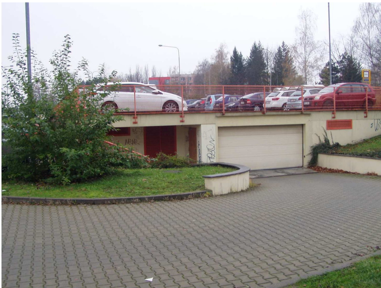
Obrázek 88: Dvoupodlažní napůl zapuštěná garáž s celkovou kapacitou 50 stání, Ostrava, ulice B. Nikodéma
